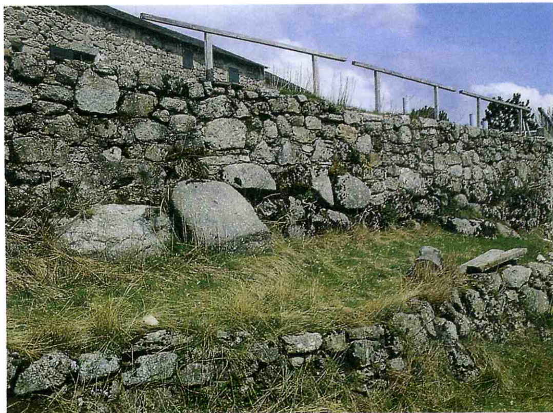
Le vieux mur de pierres: à conserver à tout prix!
