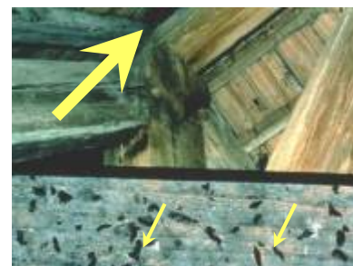
guano au pied d'un recoin de charpente où se logent des chauves-souris
