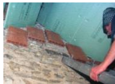
Pose de briques creuses dans une maison forestière
