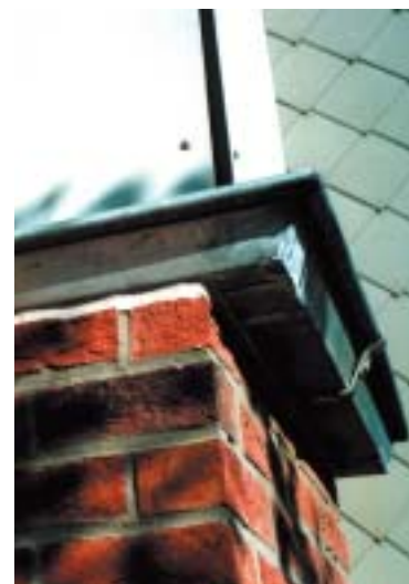
Gouttière en zinc
