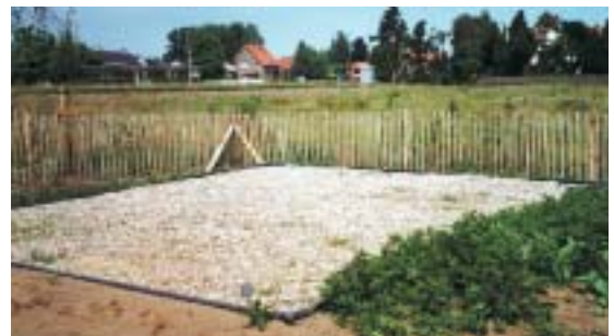
Un filtre planté de roseaux, en construction (voir B.1. p.69)
